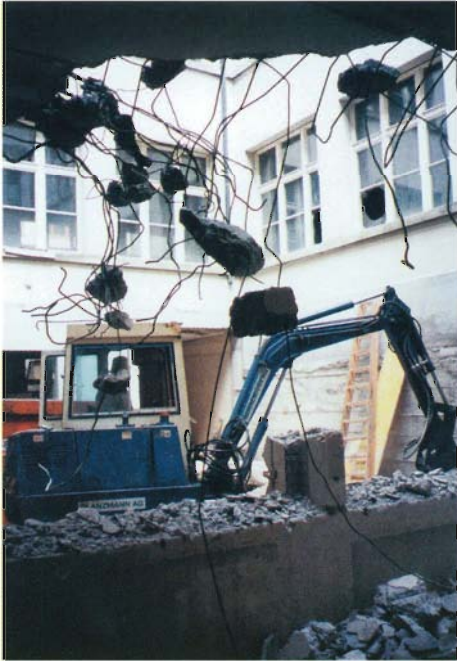
Abbruch auf engstem Raum
