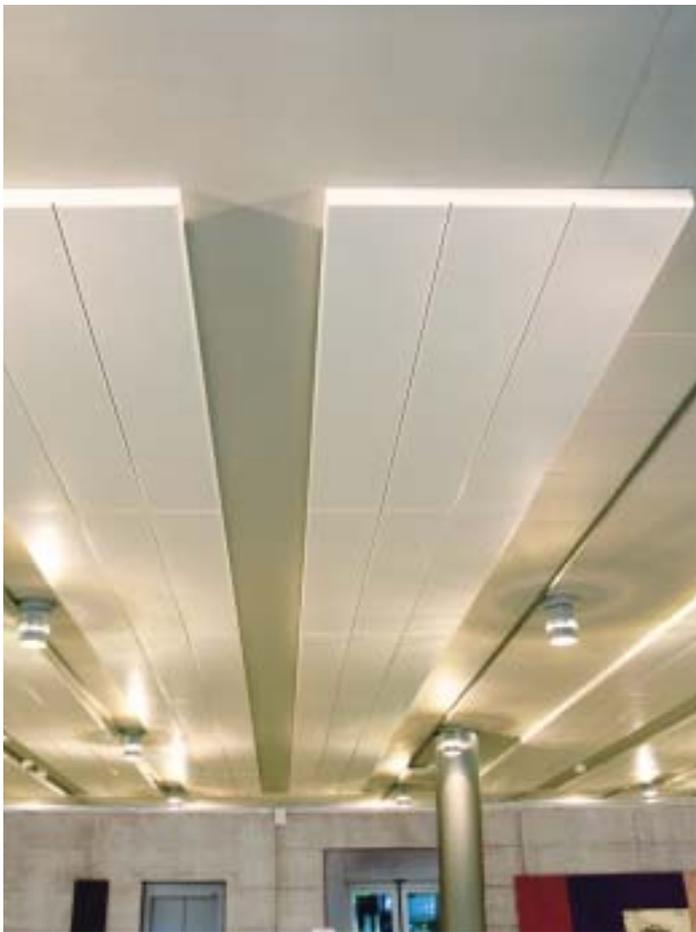
Weltpremiere (Akustikthermplus): Die wärmeleitenden Deckenelemente für die Kühlung und Heizung wirken gleichzeitig als Schallsolation
