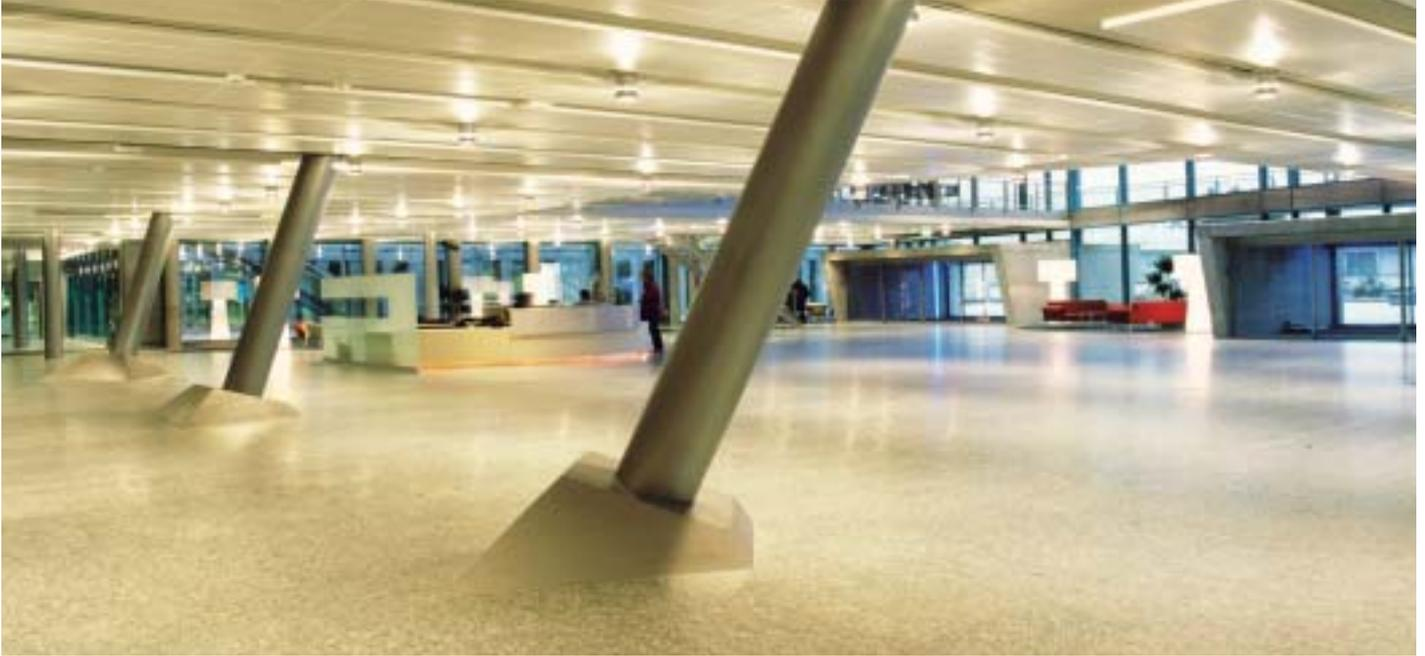
Die spezielle Dachkonstruktion mit der Spannweite von 28 Metern wird von schrägen Säulen getragen.
