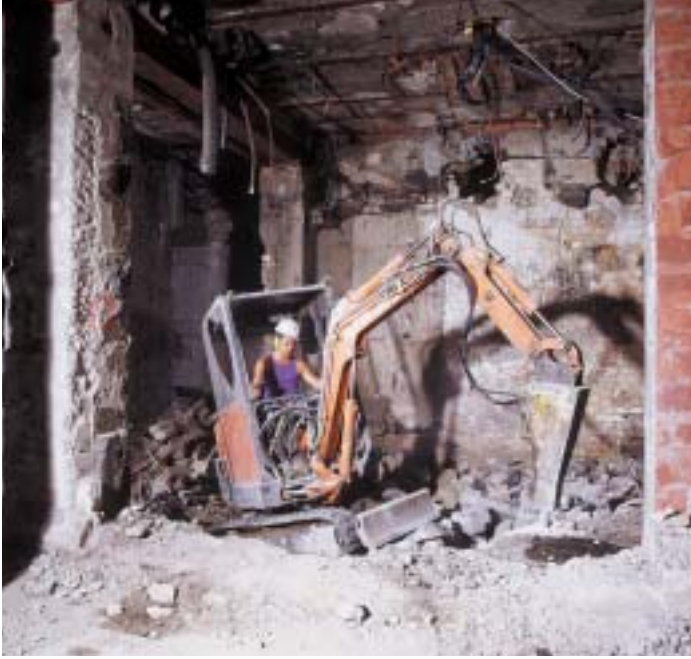
Abbruch auf engstem Raum.
