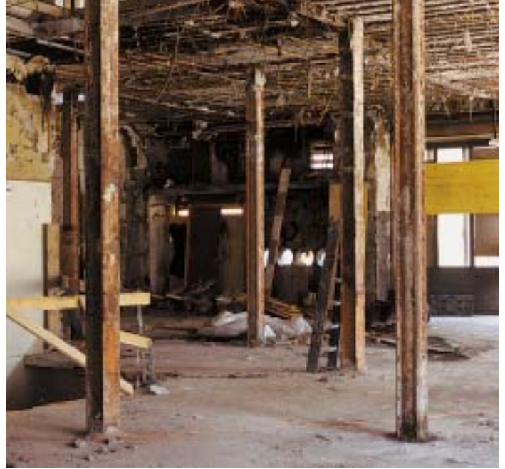
Anspruchsvolle Arbeiten unter gefährlichen Bedingungen.
